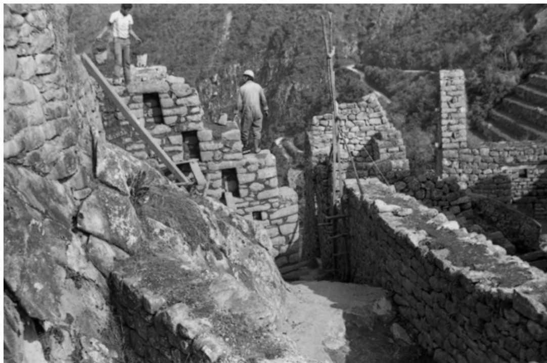
Figura 37. Recomposición del muro de acceso al conjunto 38 (Templo del Cóndor) (fuente: Taca 1991).
