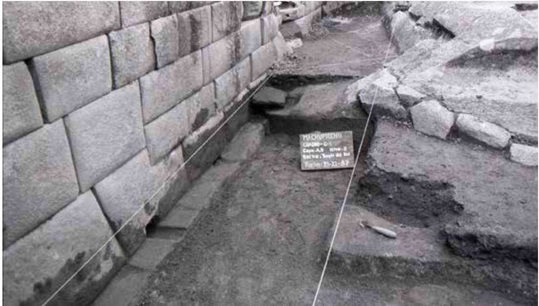
Figura 31. Dren del muro norte del Templo del Sol (señalado por la flecha) (fuente: Ramos 1987).
