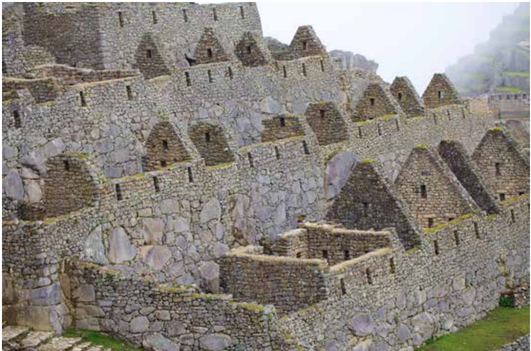
Figura 2. Muros de sostenimiento (marcados con A); nótese las grandes dimensiones de sus elementos líticos (fotografía: José M. Bastante).
