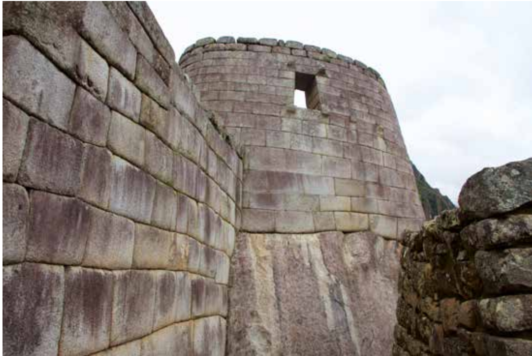
Figura 15. Elementos líticos del Templo del Sol que estaban siendo pulidos para darle un acabado sedimentario (fotografía: José M. Bastante).
