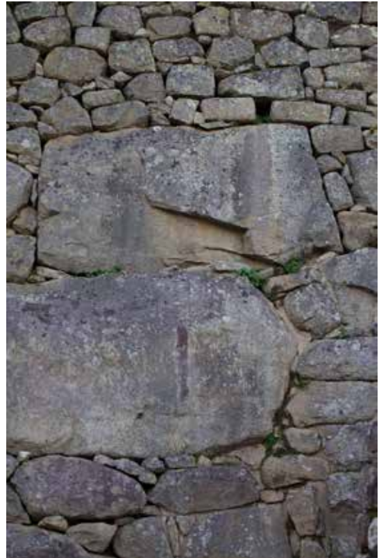
Figura 7. Detalle del canal de evacuación pluvial (fotografía: José M. Bastante).
