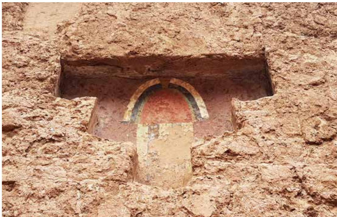
Figura 3. Revoque, enlucido y pintura, Casa de Sayri Túpac, Yucay.
