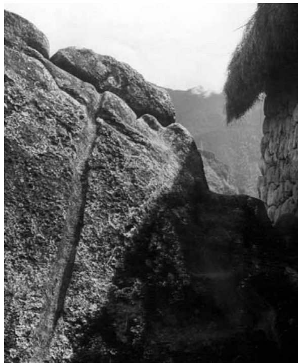
Figura 23. Con el objeto de evitar que el agua que caía de los techos de paja se infiltre en la zona de cimentación, se utilizó un canal de goteo para interceptar el agua. Aquí, en la wayrana de la Roca Sagrada, el techo de paja original era mucho más denso que el reconstruido por el doctor Valencia Zegarra.
