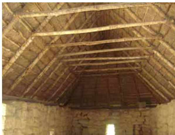
Figura 25. Recinto de la qolqa , con estructura de madera del techo a cuatro vertientes; en la parte central se aprecia el diseño del tijeral de tipo par-nudillo; al fondo la vertiente lateral.
