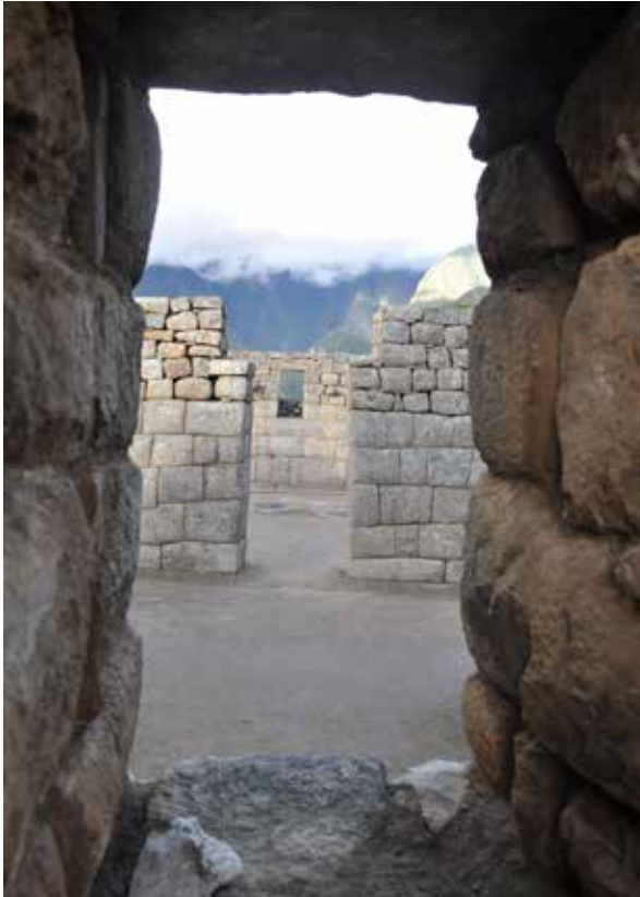
Figura 32. Ventana del muro divisorio de la wayrana doble; al fondo, la ventana de observación astronómica.
