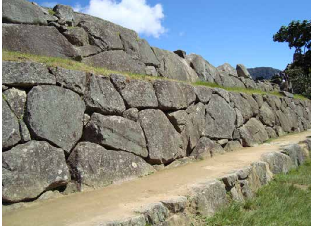
Figura 11. Andenes con muros de aparejo poligonal ciclópeo. Se aprecia la biodiversidad de la flora natural.
