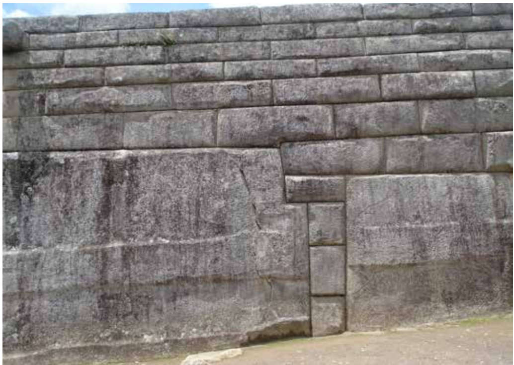
Figura 12. Detalle central del muro anterior: piezas megaciclópeas de cantería depurada y encima líticos de estilo rectangular isódomo.
