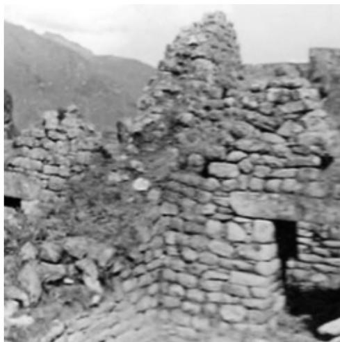
Figura 8. Muro central de la huayrana mostrando la superficie de fractura en su prolongación; 1969.
