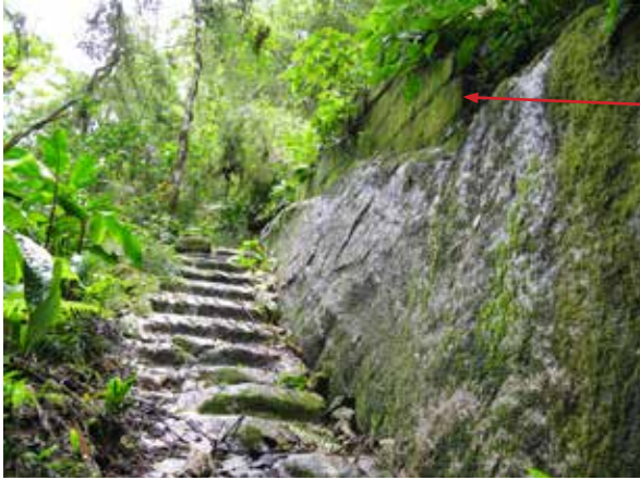
Figura 40. Peldaños trabajados en la roca madre al inicio del camino, a unos pocos metros del lecho del río (fotografía: Alicia Fernández).
