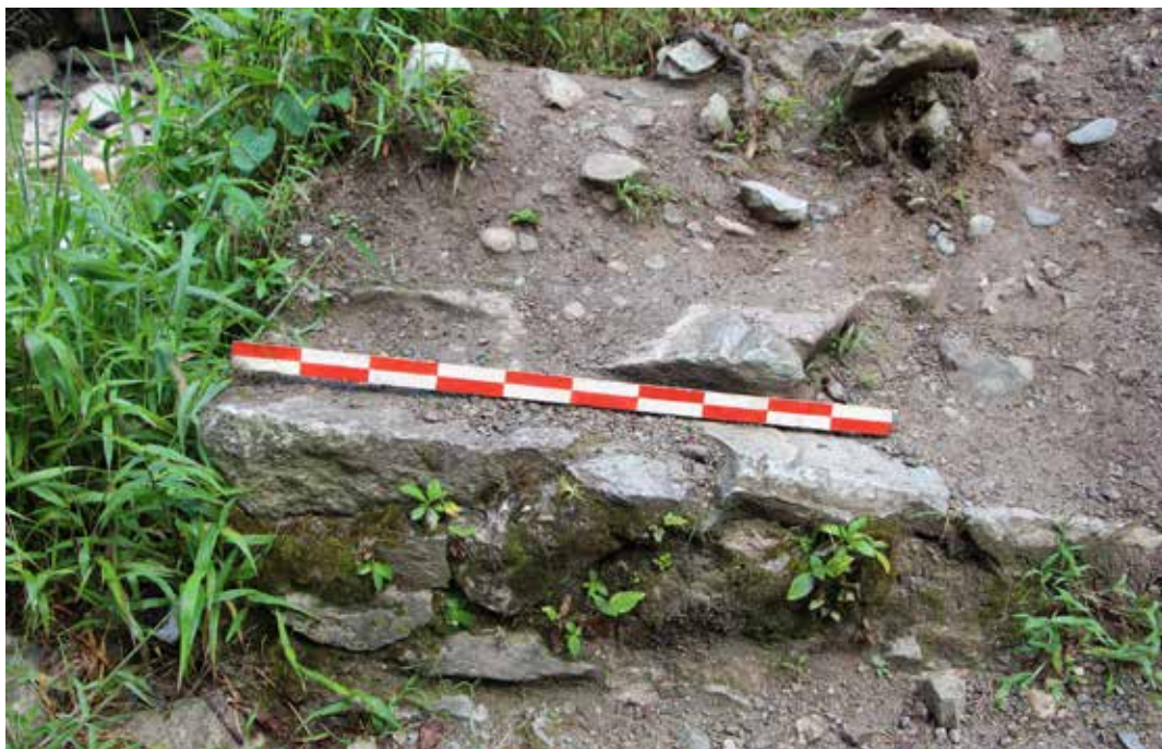
Figura 25. Estribo del puente inka de San Miguel (fotografía: José M. Bastante).
