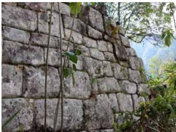
Figura 12. Detalle del tipo de arquitectura almohadillada de la estructura del mirador de Inkaraqay (fotografía: Alicia Fernández).
