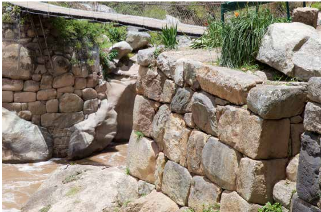
Figura 33. Estribos del puente Qoriwayrachina I (fotografía: José M. Bastante).
