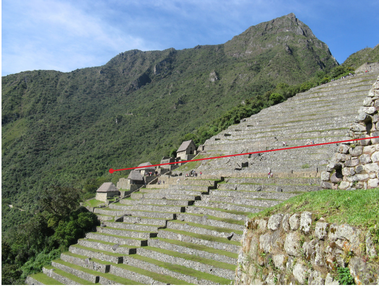
Figura 1. Vista general del flanco oriental de la montaña Machupicchu con la ubicación del canal de captación.
